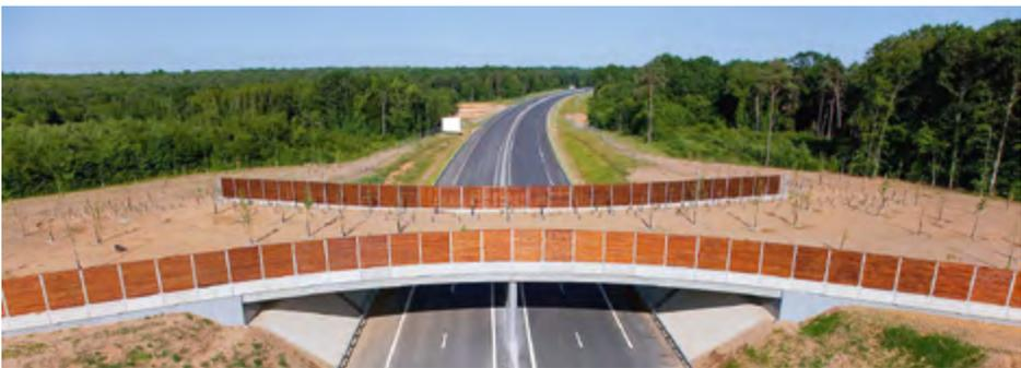
**Figure D10 – Aménagement d'un passage grande faune au-dessus de l'autoroute A19.**
