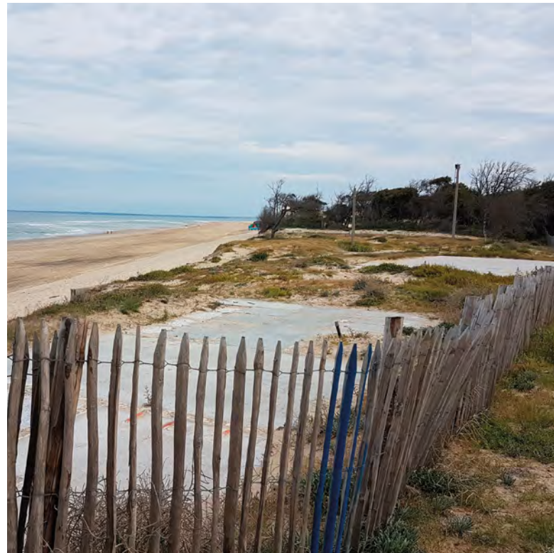
Cordon dunaire dégradé © Communauté de communes Médoc Atlantique
