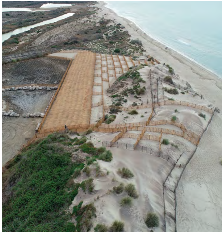
Vue aérienne du site après travaux © SYMADREM
