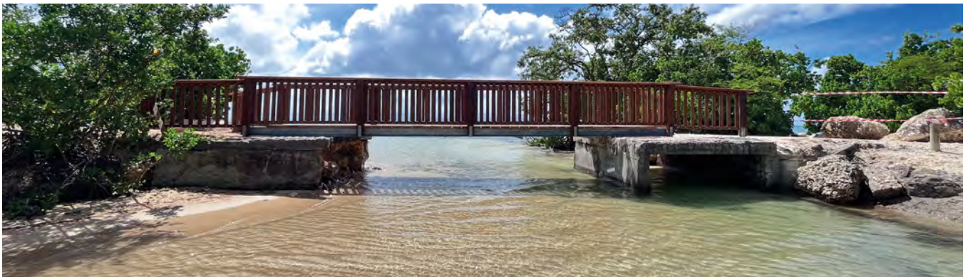
Après travaux Nouvelle passerelle piétonne © ONF
