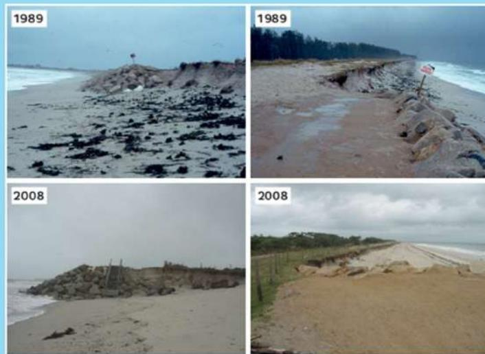
**Figure 26 : évolution de « l'effet de bout » à l'extrémité est de l'enrochement entre 1989 (deux ans après la pose) et 2008 (après la tempête Johanna du 10 mars 2008). A gauche : photo de l'extrémité de l'ouvrage prise sur la plage en direction de l'ouest ; à droite : photo prise du sommet de l'ouvrage en direction de l'est.**
