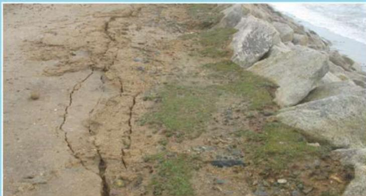
*Figure 27 : dégradation de l'extrémité d'un enrochement. En haut : structure de l'extrémité de l'ouvrage de Cleut-Rouz(1) ; érosion du revêtement au sommet de l'ouvrage par ravinement dû aux projections de paquets de mer et d'infiltrations (2). En bas : conséquences des projections de paquets de mer sur le sommet des enrochements.*
