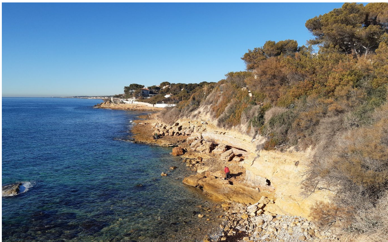
Figure 24 : Falaise caractérisée par la présence de terrain meubles au-dessus des niveaux rocheux à l'ouest de la Pointe des Moulins (source : BRGM, 2023)
