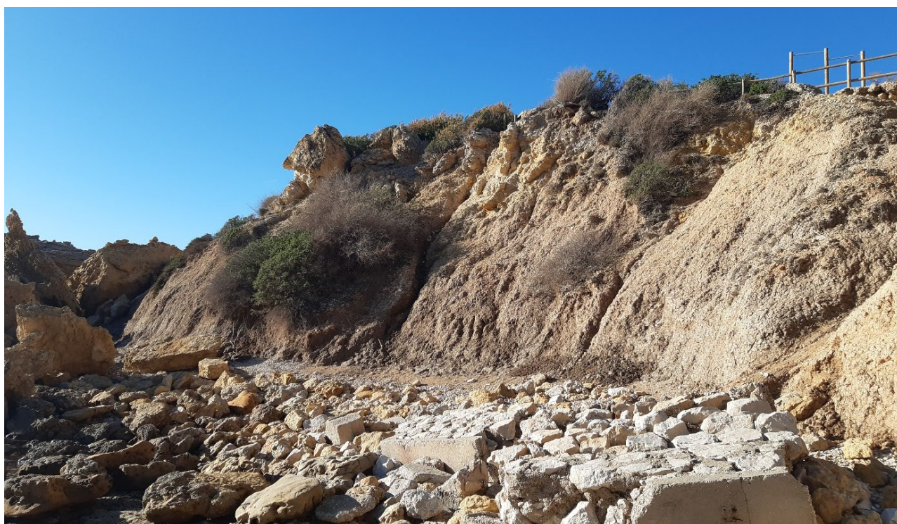
Figure 23 : Falaise caractérisée par la présence de niveaux marneux coiffés de formations rocheuses (calcarénite) © BRGM
