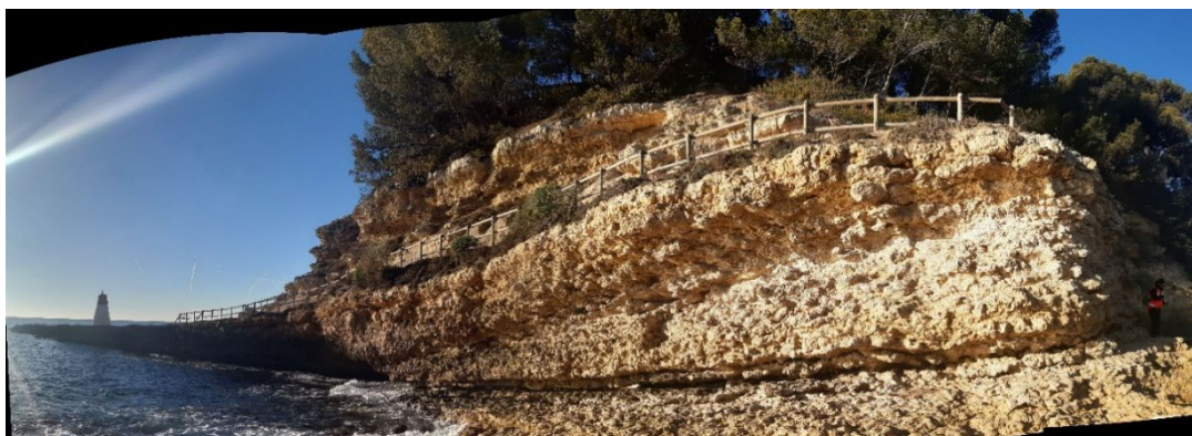
Figure 15 : Surplomb en contrebas du sentier évoluant au sud en sous-cavage sous le sentier © BRGM
