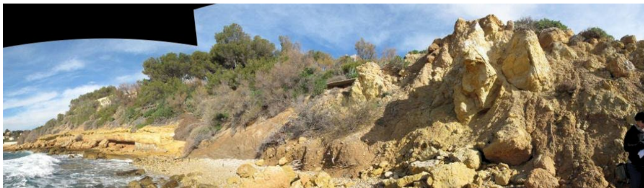
Figure 22 : Vue d'ensemble de la Pointe des Moulins (face ouest) montrant des cahors de blocs et déstabilisations de niveaux rocheux en amont de niveaux marneux © BRGM
