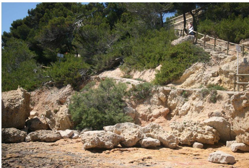
Figure 18 : Talus rocheux avant mise en place du gabion bois en contrebas du sentier (2013 © ONF)
