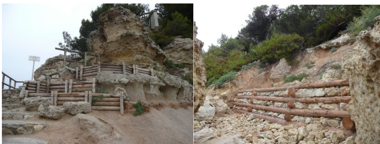
Figure 19 : Gabion bois après installation en 2014 © BRGM
