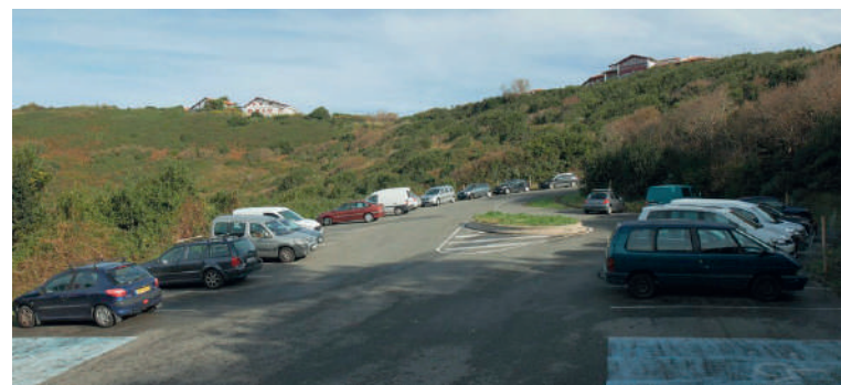
Avant travaux Site de l'ancien parking © Département des Pyrénées-Atlantiques
