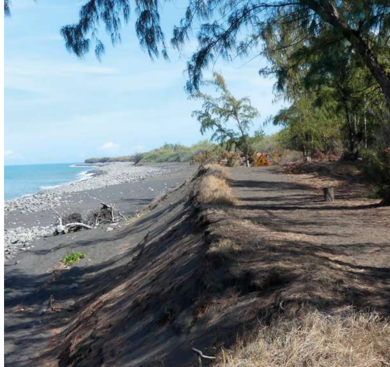
Avant travaux Plage de Cambaie (2010) © Commune de Saint-Paul
