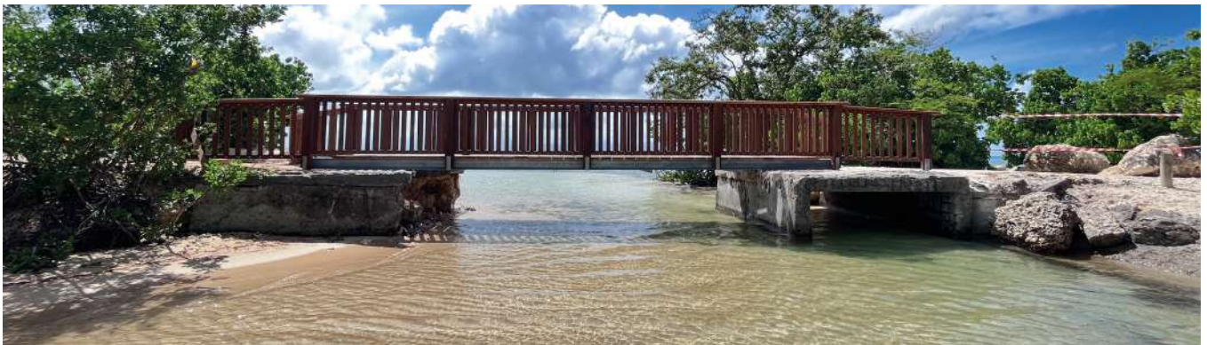
Après travaux Nouvelle passerelle piétonne © ONF
