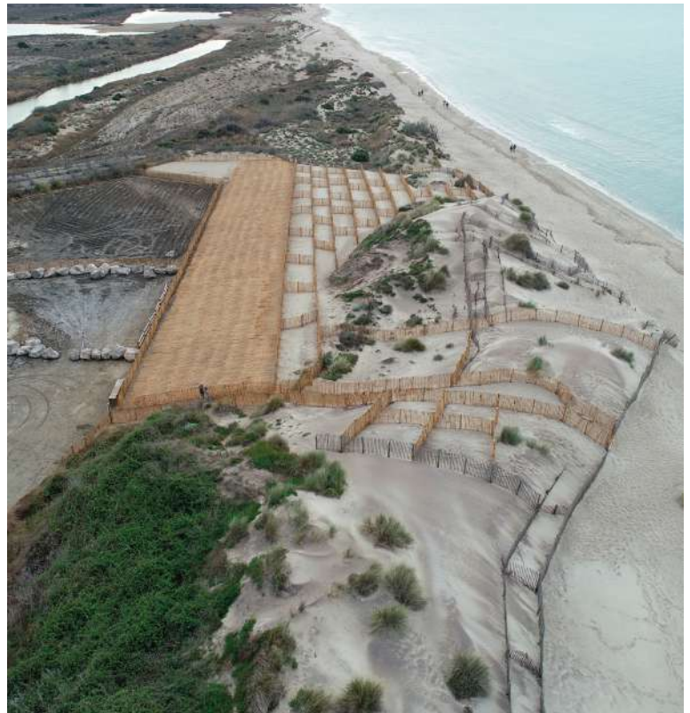
Vue aérienne du site après travaux © SYMADREM
